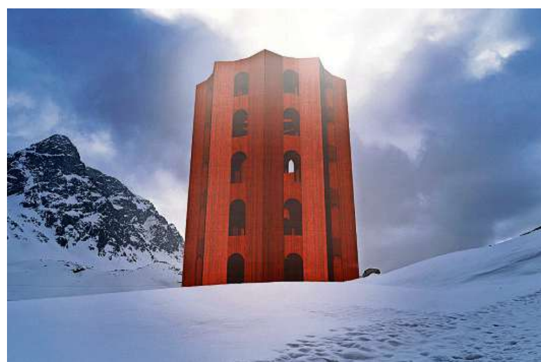
Gewappnet für jede Jahreszeit: Während im Turm im Sommer die Sicht in den Himmel frei ist, wird jeweils im Herbst ein winterfestes Dach montiert.
