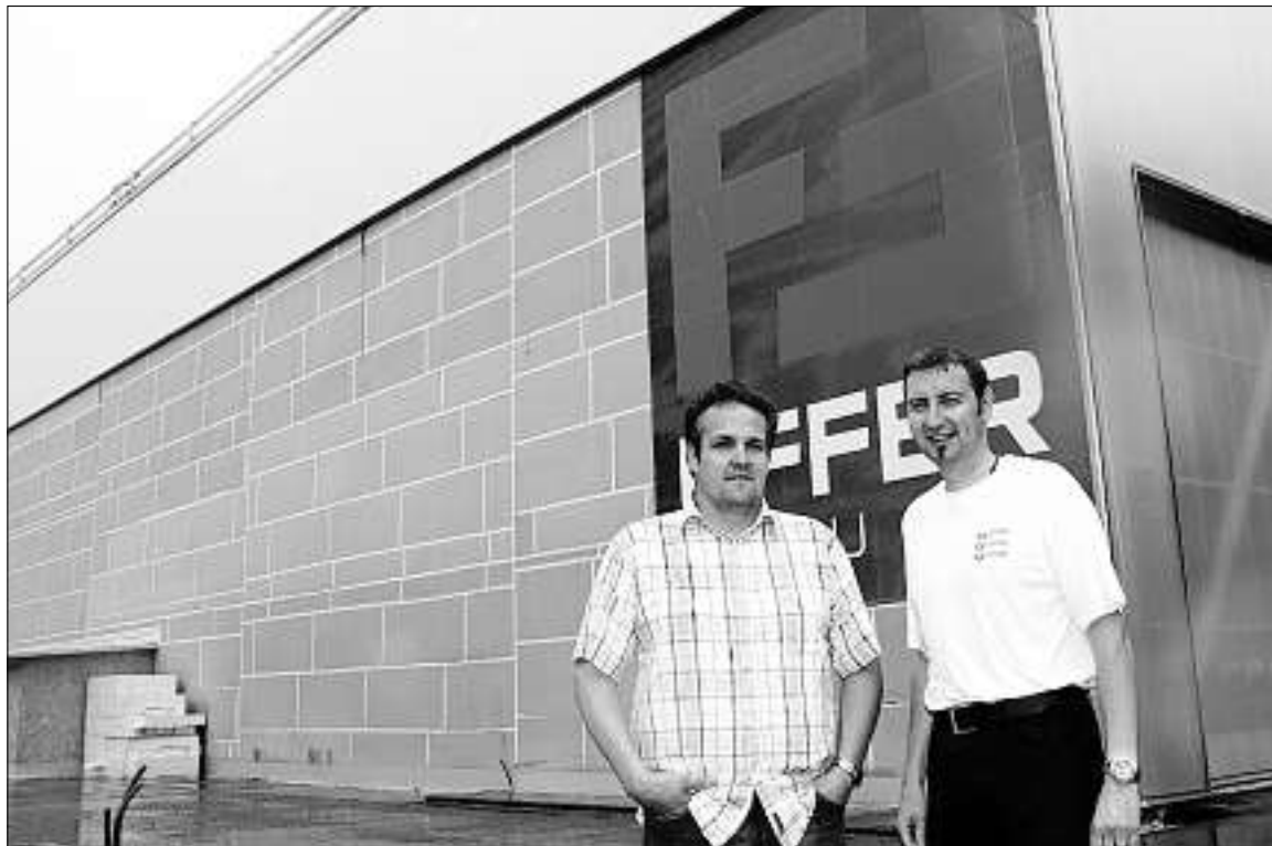
Freuen sich gemeinsam über das gelungene und ganz spezielle Bauwerk an der Julierstrasse ausgangs Savognin in Richtung Tinizong: Enrico Uffer (links) und James Cristallo. (Foto Curdin Guidon)
